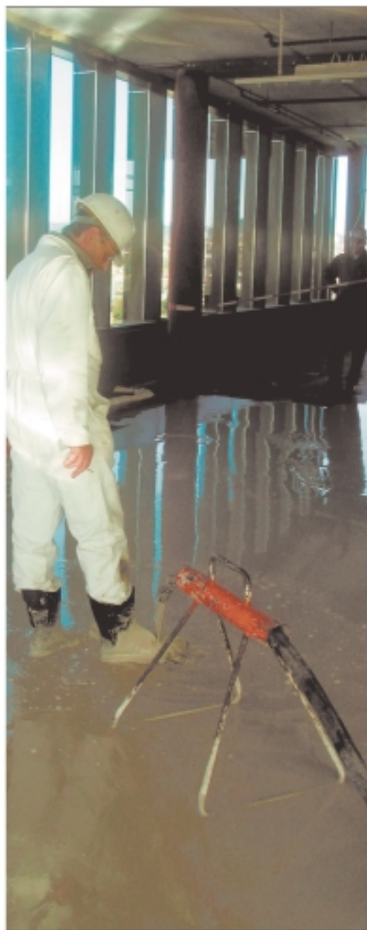
NØYE OVERVÅKET. Den tyske spesialrådgiveren, Herr Roppert følger nøye med når massen blir pumpet ut på gulvet.
